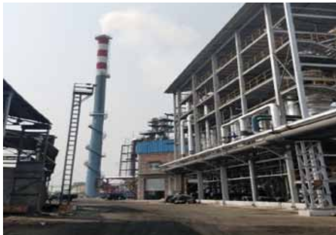
Fig-13& Fig-14: Actual MEPA Installation at DSW
